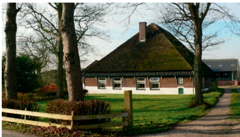
De bijgebouwen staan achter de achtergevel van de woning. Hierdoor heeft het voorerf een karakteristieke groene aanblik.
