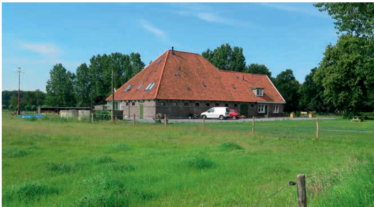
In een open weidevogelgebied kan een erfrand rond een in de streek passende bebouwing ook prima zonder beplanting blijven.
